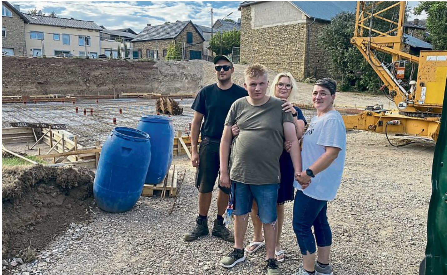
Hier entsteht der Neubau, in dem auch Leon Arns (vorne) bald leben wird: Bruder und Bauherr Luca Arns (l.), Mutter Manu Arns und Assistentin Patricia Tholl (r.) stehen auf der Baustelle, wo gerade die Bodenplatte für das Haus fertiggestellt wird. Foto: Heike Nickel
